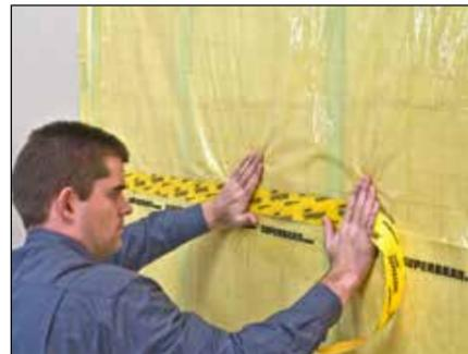
6. Die Folienüberlappungen der Dampfbremsschicht mit den Klebebandern SUPERCRAL oder SUPERFORTE spannungsfrei und luftdicht verkleben. Staubablagerungen vorher mit einem Tuch abwischen.
