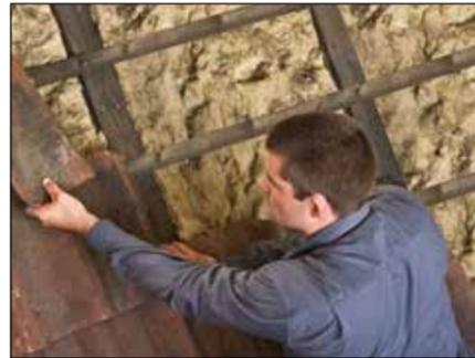
1. Alte Dacheindeckung aufnehmen, Traglatten und Konterlatten entfernen. Je nach Witterung abschnittsweise vorgehen, Dachfläche sofort wieder verschließen bzw. eine schlagregendichte Notabdichtung vorsehen.
