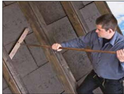
2. Alten Dämmstoff fachgerecht ausbauen und entsorgen, Gefache ausräumen und ausfegen. Sparren und Dachüberstände bei Bedarf weit genug verlängern und fachgerecht gegen späteres „Absacken“ aussteifen.
