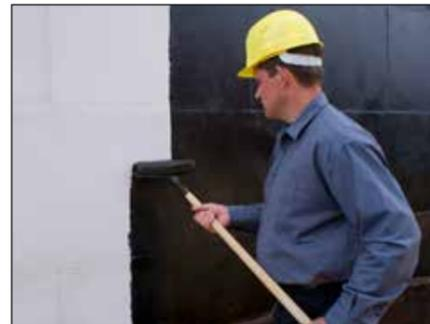
1. Als Abdichtung gegen Feuchtigkeit aus dem Erdreich die Außenwand zuerst mit einer Bitumengrundierung – je nach Beschaffenheit des Bauteiluntergrundes ein- oder mehrmalig – einstreichen. Herstellerverarbeitungshinweise beachten.
