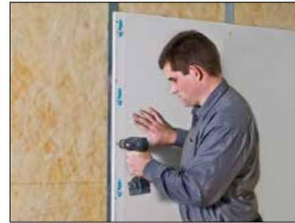
6. Abschließend die vorderseitige Beplankung aus OSB-/Gipskartonplatten montieren. Auch hier sollte man darauf achten, dass die Platten mit versetzten Stößen angeordnet und Kreuzfugen vermieden werden.
