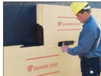
6. Im drückenden Grundwasser die Plattenfugen und -stöße verspachteln. Dadurch wird ein Hinterströmen und Aufschwimmen der Hartschaumplatten verhindert und die Dämmwirkung der Dämmschicht bleibt dauerhaft erhalten.
