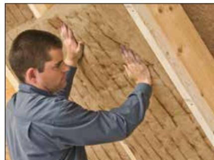
3. SUPERGLASS-KLEMMFILZ KF 4 – 032 in entsprechender Dicke gemäß der aktuell gültigen EnEV ein- oder mehrlagig in die Gefache einpassen und auf einen fugendichten Anschluss an die umliegende Konstruktion achten.
