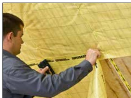
5. SUPERBRANTRIO Dampfbremsfolie mit 10 cm Überlappung von oben nach unten gerade, falten- und spannungsfrei quer zum Sparren verlegen und mit einem Handtacker fixieren. Die beschriftete Folienseite zeigt zum Verarbeiter.
