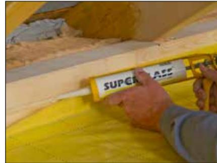
1. SUPERBRANTRIO Dampfbremssolie mit Übermaß für Folienüberlappungen vollflächig auslegen und zum Anschluss an die umliegenden Bauteile wie Fußpfetten und Giebelwände entsprechend seitlich mindestens 10 cm hochklappen.
