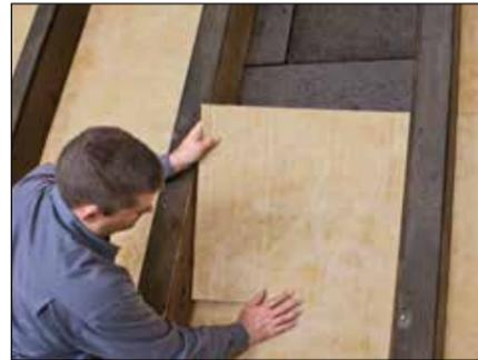
3. Zum Schutz der SUPERBRANTRIO Dampfbremsfolie vor Beschädigungen durch Nägel oder Schrauben die SUPERGLASS TRITTSCHALLDÄMMPLATTEN TS - 032 mit 5 mm Übermaß fugendicht in die Gefache einpassen.
