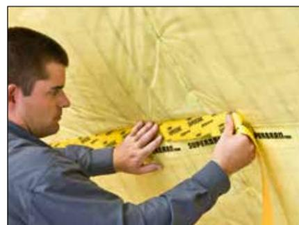
6. Folienüberlappungen der Dampfbremsfolie mit den Klebändern SUPERCAL oder SUPERFORTE spannungsfrei und luftdicht verkleben. Staubablagerungen vorher mit einem Tuch abwischen.
