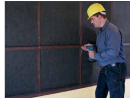
3. Das waagerechte Unterkonstruktionsholz (2. Lage) anschrauben (Abstand: Dämmstoffbreite – 5 mm). Es ist zwar nicht mehr zwingend erforderlich, aber durchaus von Vorteil, imprägniertes Holz zu verwenden.
