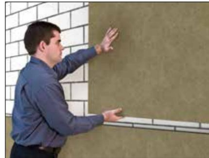
1. Die HAUSTRENNWANDPLATTEN HTP - O35 in den Wandzwischenraum einstellen und an der ersten Mauerwerksschale vorübergehend fixieren. Dabei sind Kreuzfugen zu vermeiden. Nur für Mauerwerk aus Dickbett- oder Dünnbettmörtel geeignet!
