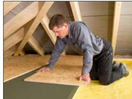
4. Die TOPDEC LOFT Dachbodendämmplatten vollflächig und dicht gestoßen auslegen, Kreuzfugen sollten vermieden werden. Leichte Unebenheiten in der Betondecke werden dabei durch die Dachbodendämmplatten ausgeglichen.
