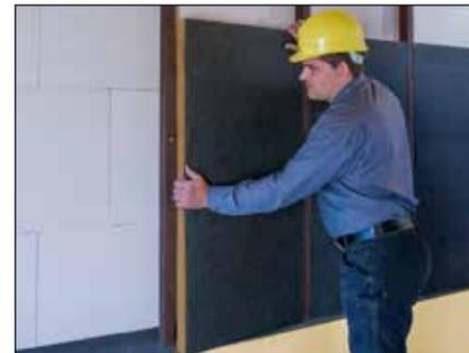
2. Feuchtigkeit oberhalb des XPS mit einer L-Folie nach außen ableiten. Das senkrechte Unterkonstruktionsholz (1. Lage) montieren und die SUPERGLASS FASSADENDÄMMPLATTEN FP 2/V fugendicht einsetzen.
