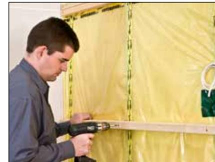
10. Danach eine Installationsebene (Zwischenmaß 62 cm) zum Schutz der Dampfbremsschicht und zur Aufnahme von Kabeln und Rohrleitungen anordnen. Zur schalltechnischen Entkopplung ein Schallentkopplungsband auf das Ständerwerk aufkleben.
