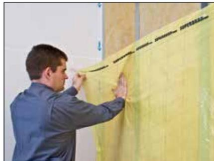
5. Die SUPERBRANTRIO Dampfbremsschicht mit 10 cm Überlappung spannungsfrei und quer zu den Profilen verlegen und mit Klebeband am CW-Metallprofil fixieren. Die beschriftete Folienseite zeigt zum Verarbeiter.
