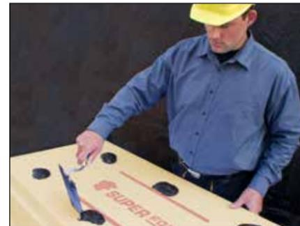
3. Im nicht drückenden Grundwasser zur Montagefixierung der SUPERFOAM 300 SF / 500 SF Hartschaumplatten an der Außenwand, die Dickbeschichtung punktuell mit einer Kelle auf den Hartschaumplatten aufbringen.
