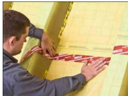
6. Folienüberlappungen und Stöße der Dampfbremsfolie SUPERBRANTRIO mit dem SUPERFORTE-Klebeband spannungsfrei und luftdicht untereinander verkleben. Staubablagerungen vorher mit einem Tuch abwischen.
