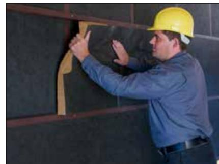
4. Den Dämmstoff fugendicht einpassen. Bei Bedarf mit 2 Tellerdübeln/Platten mechanisch fixieren. Als zusätzlicher Schutz kann eine diffusionsoffene Unterdeckbahn montiert und winddicht mit SUPERFORTE-Klebeband verklebt werden.
