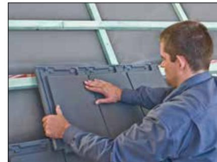
12. Nageldichtband (z. B. ISOVER VARIO ANTISPIKE oder baugleich) auf die Unterdeckbahn im Sparrenbereich aufbringen, Konterlattung und Traglattung entsprechend verlegen und abschließend die neue Dacheindeckung herstellen.
