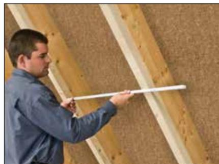
1. Abstand zwischen den Sparren und Kehlbalken ausmessen und 1 cm Klemmzugabe begeben. Bei Bedarf eine „Aufdoppelung“ der Sparren, z. B. mit hochkant aufgeschraubten 4 x 6er Konstruktionsholz, vornehmen.
