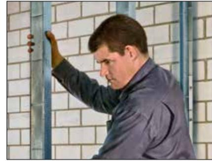
3. Die CW-Profile im Rastermaß von 62,5 cm (bei OSB bis zu 124,5 cm Achsmaß) in die auf dem Boden und an der Decke angebrachten UW-Profile einstellen, lotrecht ausrichten und mit SUPERFORTE oder einer Nietzange fixieren.
