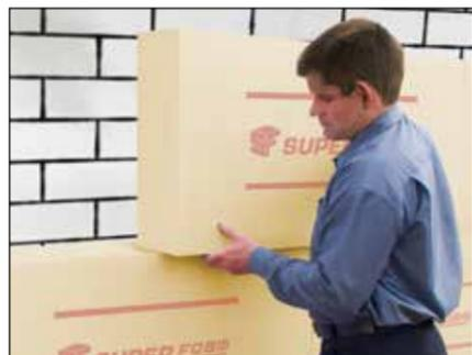
B. Die Hartschaumplatten in maximal 4 cm Dicke waagrecht von unten nach oben mit versetzten Stößen an der Außenwand anbringen und lotrecht bzw. flächig ausrichten. Hervorstehende Kanten an den Plattenfugen sind zu vermeiden.
