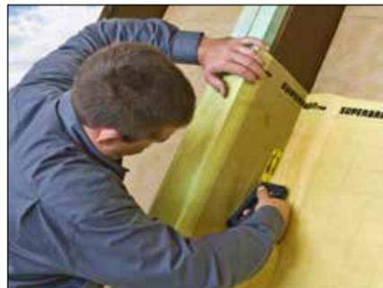
5. SUPERBRANTRIO Dampfbremsfolie schlaufenförmig um die Sparren herum verlegen, quer in die Gefache locker einpassen und mit einem Nageldichtband an der unteren Sparrenwanne fixieren. Die beschriftete Folienseite zeigt zum Verarbeiter.
