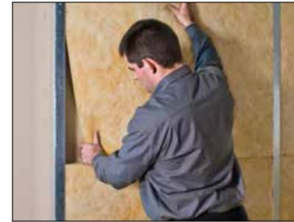
5. Für optimalen Schall- und Brandschutz die SUPERGLASS TRENNWANDPLATTEN TW 1 – O40 dicht gestoßen in das Ständerwerk einstellen. Der Dämmstoff sollte bei hoher Baufeuchte 2 cm dünner als die Profiltiefe sein.
