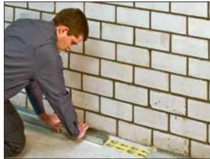
1. Die UW-Metallprofile mit Abstand zur Außenwand auf dem Boden und an der Decke fixieren. Zur schalltechnischen Entkopplung von den umliegenden Bauteilen ein Schallentkopplungsband/einen Steinwollestreifen verwenden.
