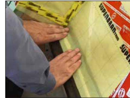
7. Mit dem SUPERGLASS-DICHTKLEBER eine 8 mm dicke Kleberaupe auf die umliegenden Bauteile wie Giebelkronen und Fußfetten auftragen und die Dampfbremsfolie spannungsfrei andrücken. Klebeflächen vorher reinigen/abfegen.
