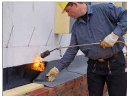
4. Zusätzlich zu der Sockelabdichtung gemäß DIN 18195 ist die L-Folie gemäß DIN EN 1996 als 2. Abdichtungsebene im Sockelbereich nicht erforderlich, kann je nach Geländeführung und Beanspruchung aber sinnvoll sein.
