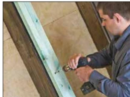
4. Die Sparren auf Tragfähigkeit prüfen und aufdoppeln. Dadurch werden die verlängerten Dachüberstände zusätzlich ausgesteift und die geforderten Dämmdicken gemäß der aktuell gültigen EnEV werden eingehalten.
