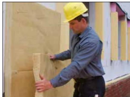
5. Die SUPERGLASS KERNDÄMM-PLATTEN KD 4/V – 032 in entsprechender Dicke gemäß der aktuell gültigen EnEV mit versetzten Stößen auf die Luftsichtanker aufstecken. An den Gebäudeecken sind durchgehende Fugen zu vermeiden.
