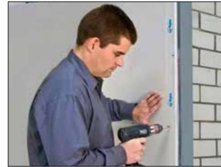
4. Die Rückseite mit OSB-/Gipskartonplatten beplanken. Dabei ist darauf zu achten, dass die Platten mit versetzten Stößen angeordnet und Kreuzfugen vermieden werden. Kontakt zu umliegenden Bauteilen ist zu vermeiden.
