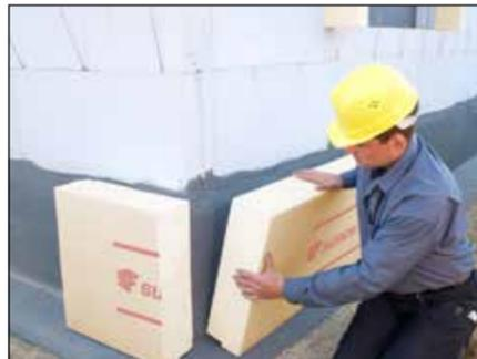
2. Unterhalb der Geländeoberkante kann je nach späterer Geländeführung gemäß DIN EN 1996 Mineralwolle oder XPS/PUR verbaut werden, z. B. SUPERFOAM 300 SF XPS oder Kingspan Therma TW50 PUR.
