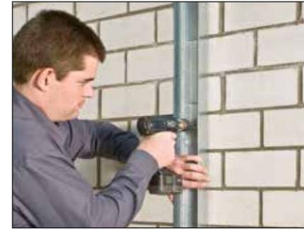
2. Die CW-Profile an den Seitenwänden mit z. B. Schlagdübeln fixieren. Auch hier je nach Brand- und Schallschutzanforderungen ein Schallentkopplungsband oder einen Dämmstreifen aus Steinwolle in Wandbreite verwenden.
