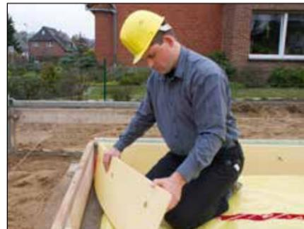
3. In die Randschalung für die Bodenplatte das SUPERFOAM 280 GKP als Wärmebrückendämmung einstellen und fixieren. Leichtbauplattenanker aus Kunststoff sichern die Hartschaumplatten dabei dauerhaft in ihrer Position.
