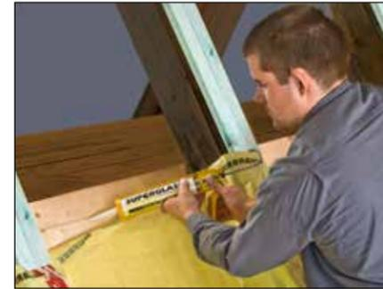
9. Zum Anschluss an die modernisierte Holzbalkendecke (siehe Seite 13) von innen an die Sparren ein Stirnbrett anbringen und daran die SUPERBRANTRIO Dampfbremsfolie mit dem SUPERGLASS-DICHTKLEBER spannungsfrei anschließen.
