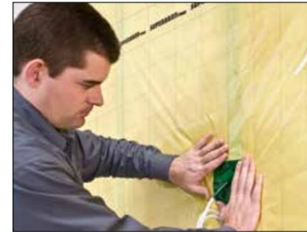
7. Die Anschlüsse der SUPERBRANTRIO Dampfbremsschicht an Durchdringungen und beweglichen Bauteilen mit den Klebebandern SUPERSAN oder SUPERFORTE luftdicht herstellen. Auch mit Fertigmanschetten möglich.
