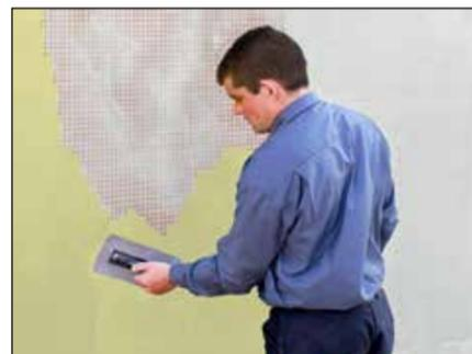
C. Nach dem Aufbringen des Grundputzes (z. B. von Fa. Weber) mit einer Zahnkelle ist das Armierungsgewebe mit Überlappungen an den Stößen vollflächig einzuarbeiten. Anschließend den Oberputz auftragen und entsprechend gestalten.
