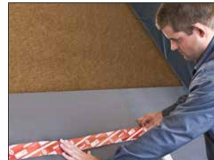
11. Als festes Unterdach und zur Erhöhung des sommerlichen „Hitzeschutzes“ können die MULTISOL 140 oder DUO-PROTECT 180 Holzweichfaserplatten aufgebracht werden. Eine Unterdeckbahn schützt zusätzlich vor Schlagregen.
