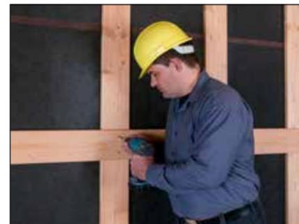
5. Senkrechte Konterlatte (3–6 cm dick, fixiert zus. die Dämmung, Achsmaß ca. 50 cm) montieren, damit evtl. Feuchtigkeit hinter den Traglatten der Außenverschalung abgeführt werden kann. Danach die waagerechte Traglattung befestigen.
