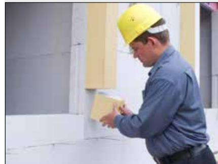
3. Als Innenputzträger im Bereich der Fenster/Türlaibungen Randdämmstreifen aus SUPERFOAM 280 GKP XPS oder Kingspan Kooltherm K5 PUR als Abschluss der Luft- bzw. Dämmschicht mit Baukleber auf dem tragenden Mauerwerk ankleben.
