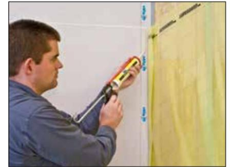
9. Mit dem SUPERGLASS-DICHTKLEBER eine 8 mm dicke Kleberaupe auf die umliegenden Bauteile wie Boden, Decke und Wände auftragen und die Dampfbremsschicht spannungsfrei als Schlaufe gefaltet andrücken.
