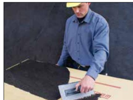
4. Im drückenden Grundwasser die SUPERFOAM 300 SF / 500 SF Hartschaumplatten mit Dickbeschichtung vollflächig einstreichen und mit der Außenwand verkleben. Zum Aufbringen der Dickbeschichtung eine Zahnkelle verwenden.
