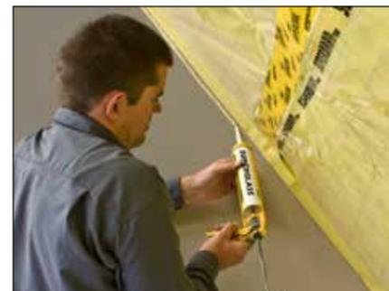
8. Mit dem SUPERGLASS-DICHTKLEBER eine 8 mm dicke Kleberaube auf die umliegenden Bauteile wie Giebelwände und Fußpfetten auftragen und die Dampfbremsfolie spannungsfrei, als Schlaufe gefaltet, andrücken.
