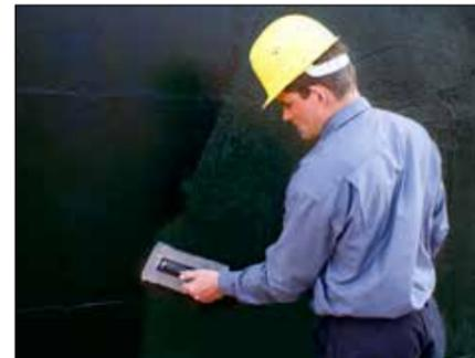
2. Anschließend die Bitumendickbeschichtung oder die bitumenfreie Dickbeschichtung mit einer Glättkelle – je nach Feuchtigkeitsbeanspruchung ein- oder mehrmalig – vollflächig auftragen. Durchtrocknungszeiten und geforderte Endschichtdicke beachten.
