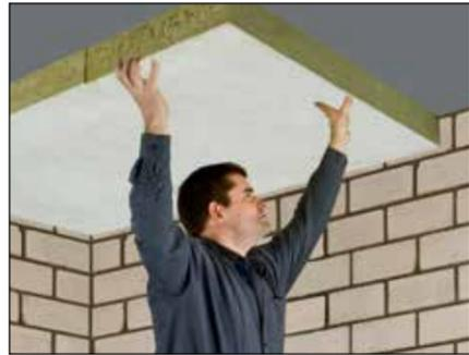
2. Die Platten fugendicht und mit versetzten Stößen an Decke und Wand ansetzen und bei Bedarf mit einem Reibebrett andrücken. Bei unebenen Untergründen kann die Montage mit entsprechenden Tellerdübeln erfolgen.
