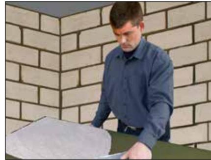
1. Auf die TOPDEC DP3 Deckendämmplatten Klebemörtel (z. B. weber.therm 370) vollflächig mit einem 10 mm Kammspachtel auf die Produktrückseite auftragen. Die seitlichen Plattenkanten bleiben kleberfrei.
