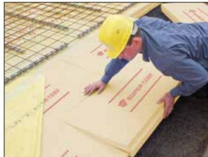
1. Auf dem tragfähigen Baugrund die SUPERFOAM 300 SF / 500 SF / 700 SF Hartschaumplatten in entsprechender Dicke gemäß der aktuell gültigen EnEV vollflächig und dicht gestoßen verlegen. Kreuzfugen sind dabei zu vermeiden.
