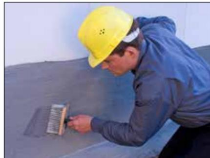
1. Den Fußpunkt mit einer Grundierung + flexiblen Dichtungsschlämme – MDS oder einer kalt-selbstklebenden Bitumendichtungsbahn – KSK vollflächig abdichten. Dabei die Durchtrocknungszeiten bzw. die DIN 18195 beachten.
