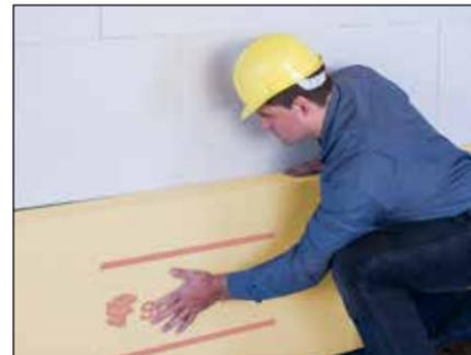
1. Den Fußpunkt mit einer kalt-selbstklebenden Bitumendichtungsbahn – KSK oder einer Grundierung + flexiblen Dichtungsschlämme – MDS vollflächig abdichten. Dabei die DIN 18195 und die Herstellervorgaben beachten.
