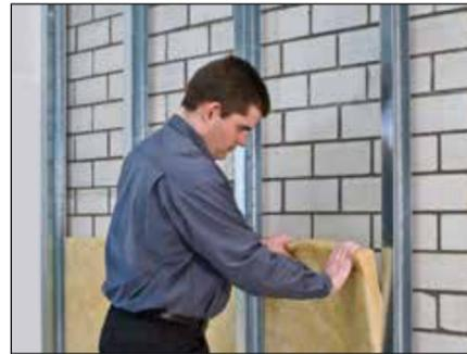
3. Zur Vermeidung von Wärmebrücken die SUPERGLASS TRITTSCHALLDÄMMPLATTEN TS - O32 zwischen dem Ständerwerk und der Außenwand vollflächig einsetzen. Dämmstoffdicken gemäß der aktuell gültigen EnEV dimensionieren.
