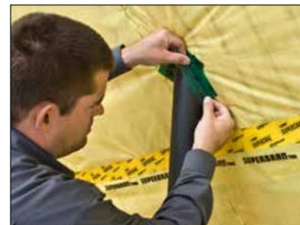
7. Anschlüsse der SUPERBRANTRIO Dampfbremsfolie an Durchdringungen und beweglichen Bauteilen mit den Klebändern SUPERSAN oder SUPERFORTE luftdicht herstellen. Auch mit Fertigmanschetten möglich.
