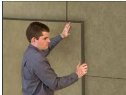
2. Bei Bedarf können die Haustrennwandplatten mehrlagig eingestellt werden. Die zweite Mauerwerksschale wird parallel zum Einstellen des Dämmstoffes Stück für Stück aufgemauert, Kontaktpunkte zwischen den beiden Schalen sind zu vermeiden!
