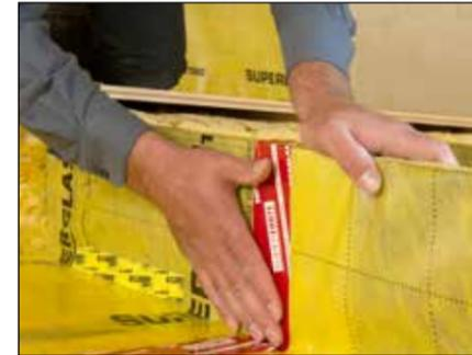
1. Die vorhandene Bodenverschalung aufnehmen und den alten Dämmstoff fachgerecht ausbauen und entsorgen. Gefache ausräumen und ausfegen. SUPERGLASS-TRITTSCHALLDÄMMPLATTE - TS als „Nagelschutz“ einsetzen.
