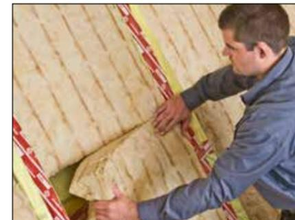
10. SUPERGLASS-KLEMMFILZ KF 4 - 032 als Vollsparrendämmung von oben in die Gefache einpassen und auf einen fugendichten Anschluss an die umliegende Konstruktion achten. Vorgaben der aktuellen EnEV berücksichtigen.
