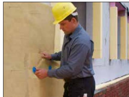
6. Abschließend die Klemmkralplatten auf die Luftsichtanker aufstecken und die Dämmung in ihrer Position fixieren. Die Luftsichtanker anschließend gemäß Zulassung mit Gefälle nach außen in die Vormauerschale einmauern.
