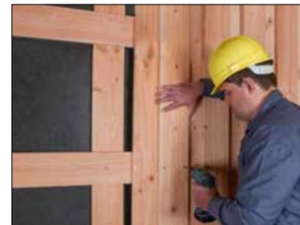
6. Nach der Montage der waagerechten Traglatten wird die Außenverschalung (z. B. eine Boden-Deckel-Schalung) montiert. Für die Konterlatten und Traglatten sollte das gleiche Holz verwendet werden wie für die abschließende Verschalung.
