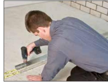
1. Die UW-Metalprofile auf dem Boden und an der Decke fixieren. Zur schalltechnischen Entkopplung von den umliegenden Bauteilen ein Schallentkopplungsband oder einen Steinwollestreifen in Wandbreite verwenden.
