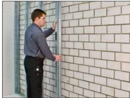
2. Die CW-Metallprofile mit max. 124,5er Achsmaß in die auf dem Boden und an der Decke angebrachten UW-Metallprofile einstellen, lotrecht ausrichten und mit SUPERFORTE oder einer Nietzange in ihrer Position fixieren.
