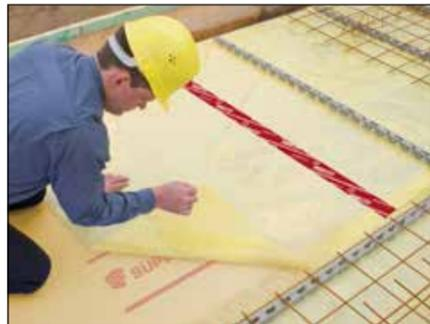
2. Um ein Eindringen des Ortbetons in die Plattenfugen zu verhindern, als Trennlage zwischen Dämmung und Bodenplatte die SUPERFOL Dampfbremsfolie auslegen und die Überlappungen falls erforderlich mit dem SUPERFORTE-Klebeband verkleben.
