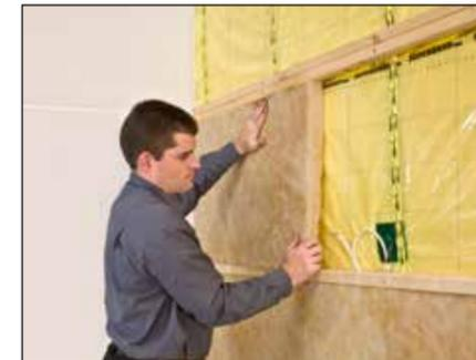
11. Den verbleibenden Hohlraum in der Installationsebene mit einer zusätzlichen Querdämmung ausfüllen. Dazu die SUPERGLASS KERNDÄMMPLATTEN KD 4/V - O32 in 62,5er Breite dicht gestoßen in die Konstruktion einpassen.
