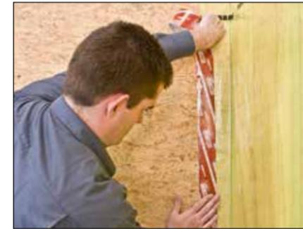
8. Im Holzrahmenbau zum Anschluss der Dampfbremsschicht an OSB-Platten das SUPERFORTE-Klebeband verwenden. Fugen und Stöße von OSB-Platten können ebenfalls mit dem SUPERFORTE-Klebeband luftdicht abgeklebt werden.
