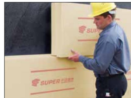
5. Die Hartschaumplatten in entsprechender Dicke gemäß der aktuell gültigen EnEV waagrecht von unten nach oben mit versetzten Stößen an der Außenwand anbringen. Der Stufenfalz ist mit Gefälle nach außen anzuordnen.
