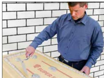
A. Auf das SUPERFOAM 280 GKP XPS den Klebemörtel (z. B. weber.therm 370) im Punkt-Wulst-Verfahren mit einer Kelle auftragen. Die seitlichen Kanten bleiben dabei klebefrei. Der Untergrund muss tragfähig und trocken sein.
