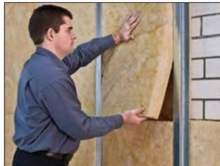
4. In das Ständerwerk die SUPERGLASS KERNDÄMMPLATTEN KD 4/V - O32 mit dem Vlies zur Außenwand einpassen. Die Dämmung sollte insgesamt mindestens 80 mm stark sein, bei Sichtfachwerkwänden höchstens 50 mm.
